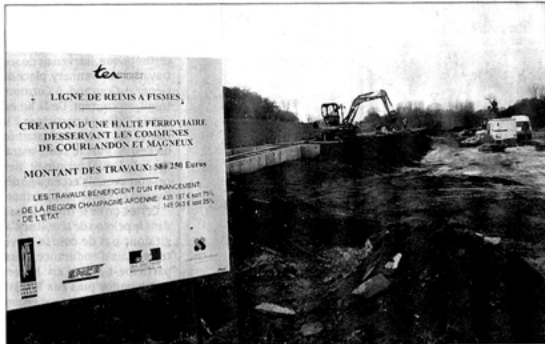
Le chantier en cours d'achèvement.
