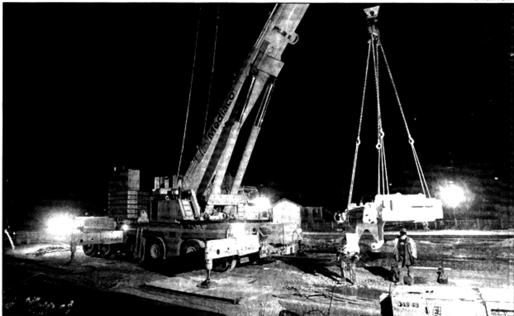
Travaux spectaculaires et nocturnes ce week-end en gare de Bazancourt.
